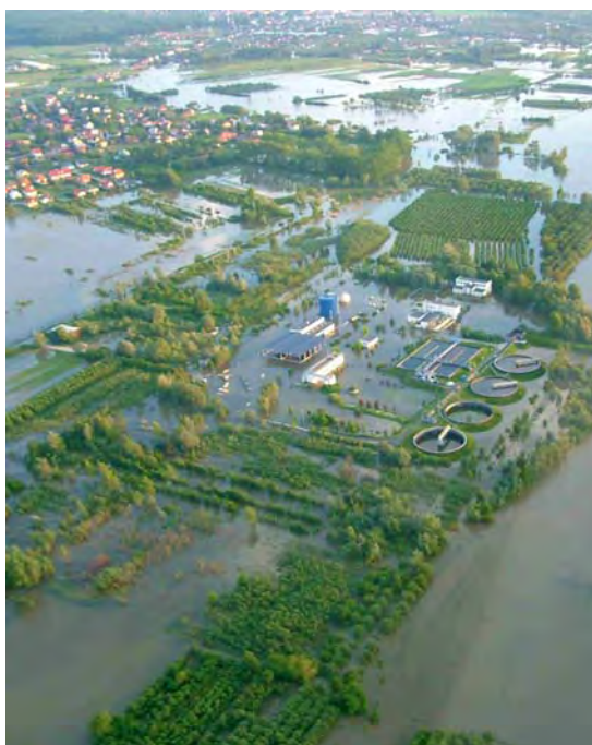
Ryc. 10.7. Zalana oczyszczalnia ścieków w Tarnobrzegu, os. Zakrzów, czerwiec 2010 r. [37]
