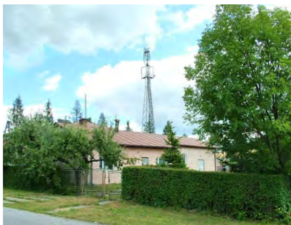
Ryc. 6.1.2. Stacja bazowa cyfrowej telefonii komórkowej w Oleszycach przy ul. Zielonej, 2006 r. [44]
