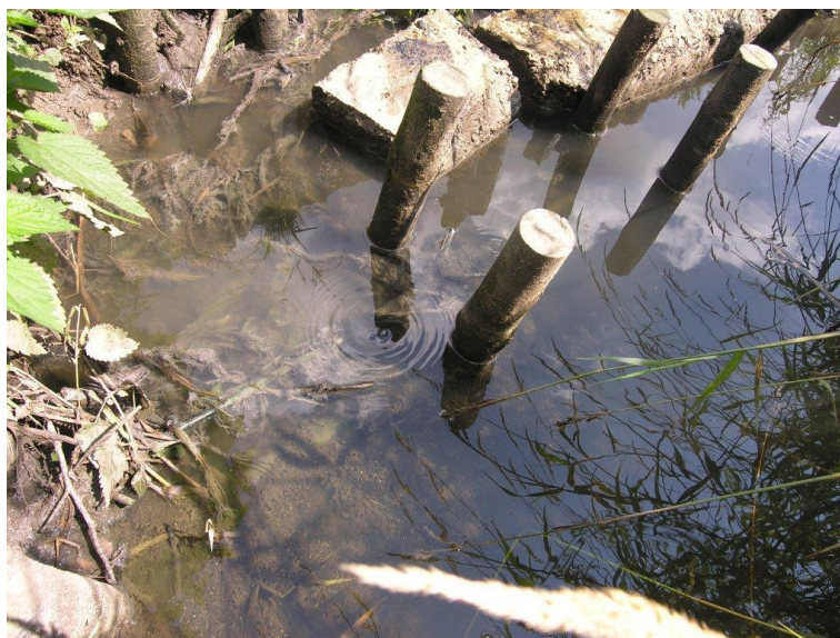
Rys. 1. Wylot kolektora ścieków z oczyszczalni w Markowej (R. Szeremeta)
